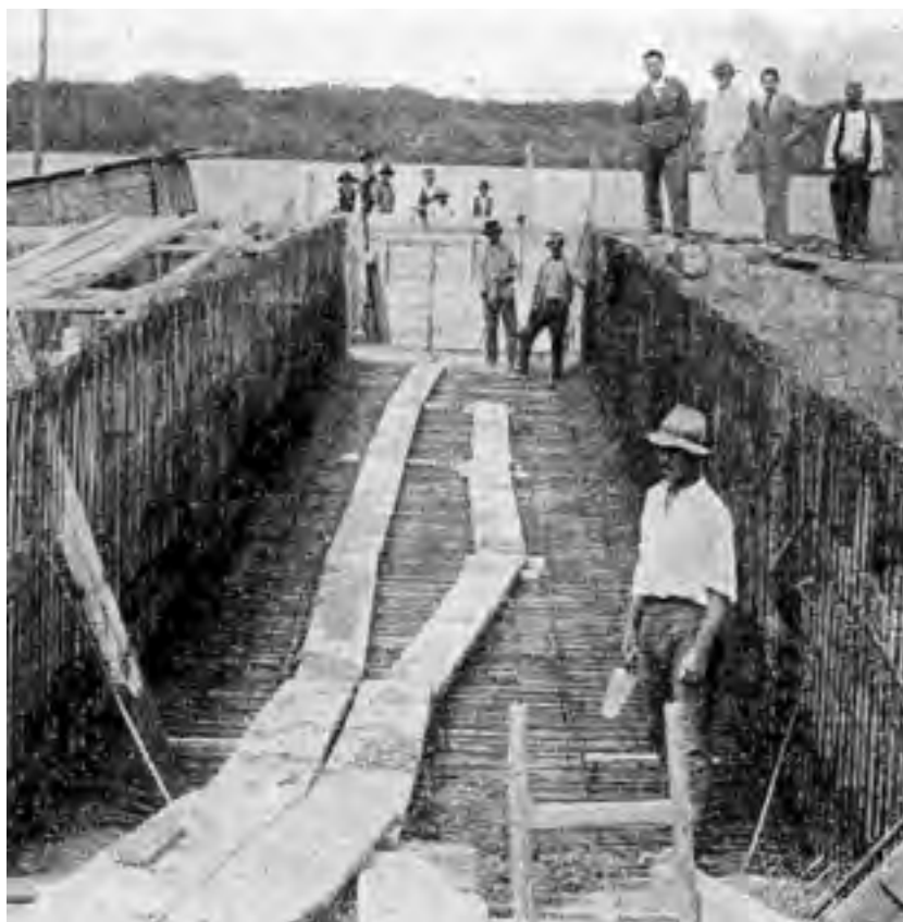
Сл. 6. Детаљ канала за израду тзв. бескрајног платна у сутерену силоса
